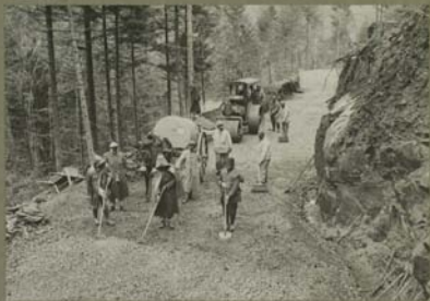
Construction de la route d'Alfeld au Ballon d'Alsace. Empierrement et cylindrage d'une partie de la route.
