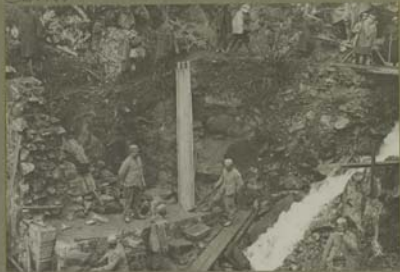
Construction de la route d'Alfeld au Ballon d'Alsace. Construction du soubassement du 2 e pont en partant d'Alfeld.
