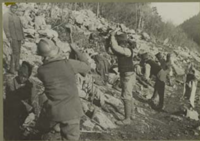
Construction de la route d'Alfeld au Ballon d'Alsace. Malgaches travaillant à ouvrir une partie de la route, forage de trous de mines.
